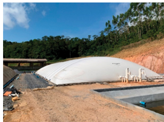
Figuras 7 e 8. Segundo biodigestor completamente cheio apto a alimentar um conjunto motogerador
