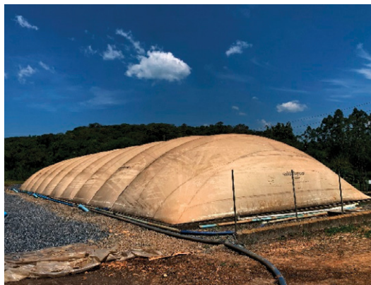
Figura 1 e 2. Biodigestor implantado em 2010, com capacidade de armazenamento de 700 metros cúbicos de biogás
