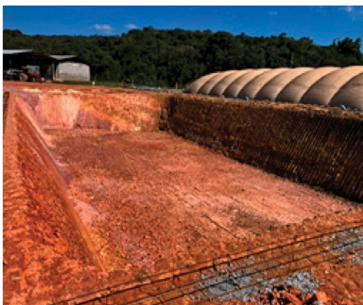
Figuras 3 e 4. Segundo biodigestor em fase de construção no ano de 2020, com capacidade de armazenamento de 1000 metros cúbicos de biogás
